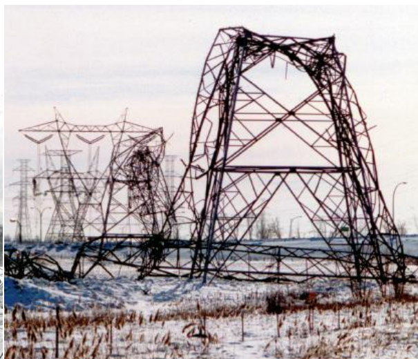
Összerogyott légvezeték tartó oszlopok [9]
