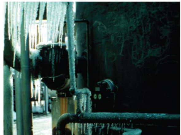
Egy éjszakára nyitva hagyott ajtó miatt elfagyott vízvezeték lyukadásának következménye [10]
