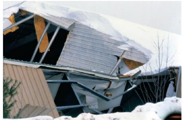
Könnyűszerkezetes építmény összerogyása hóteherből [9]
