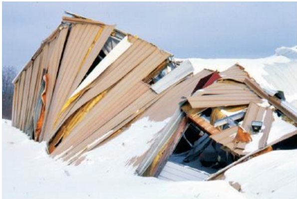
Könnyűszerkezetes építmény összerogyása hóteherből [9]
